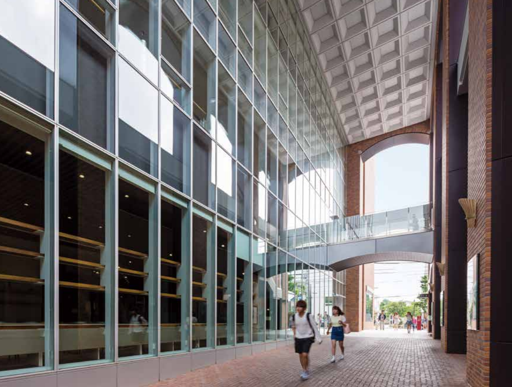
外光が差し込む4層吹抜けの「キャンパスガレリア」
